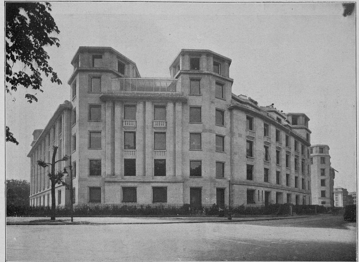
Groupe d'immeubles au Bois de Boulogne : Jean WALTER, Architecte. — Pan coupé sur l'avenue de St-Cloud (Bois de Boulogne).
