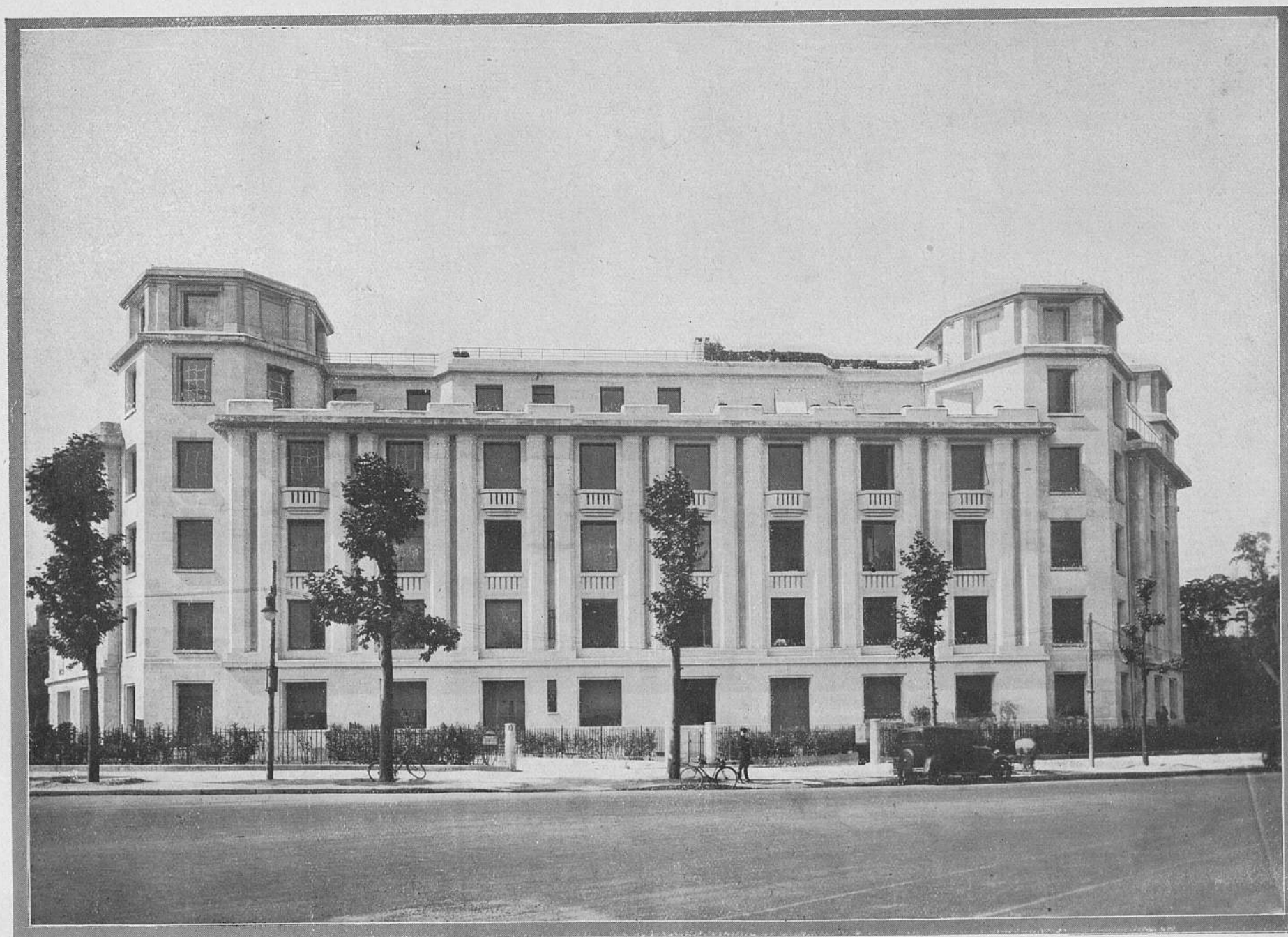
GROUPE D'IMMEUBLES AU BOIS DE BOULOGNE : JEAN WALTER, Architecte.
