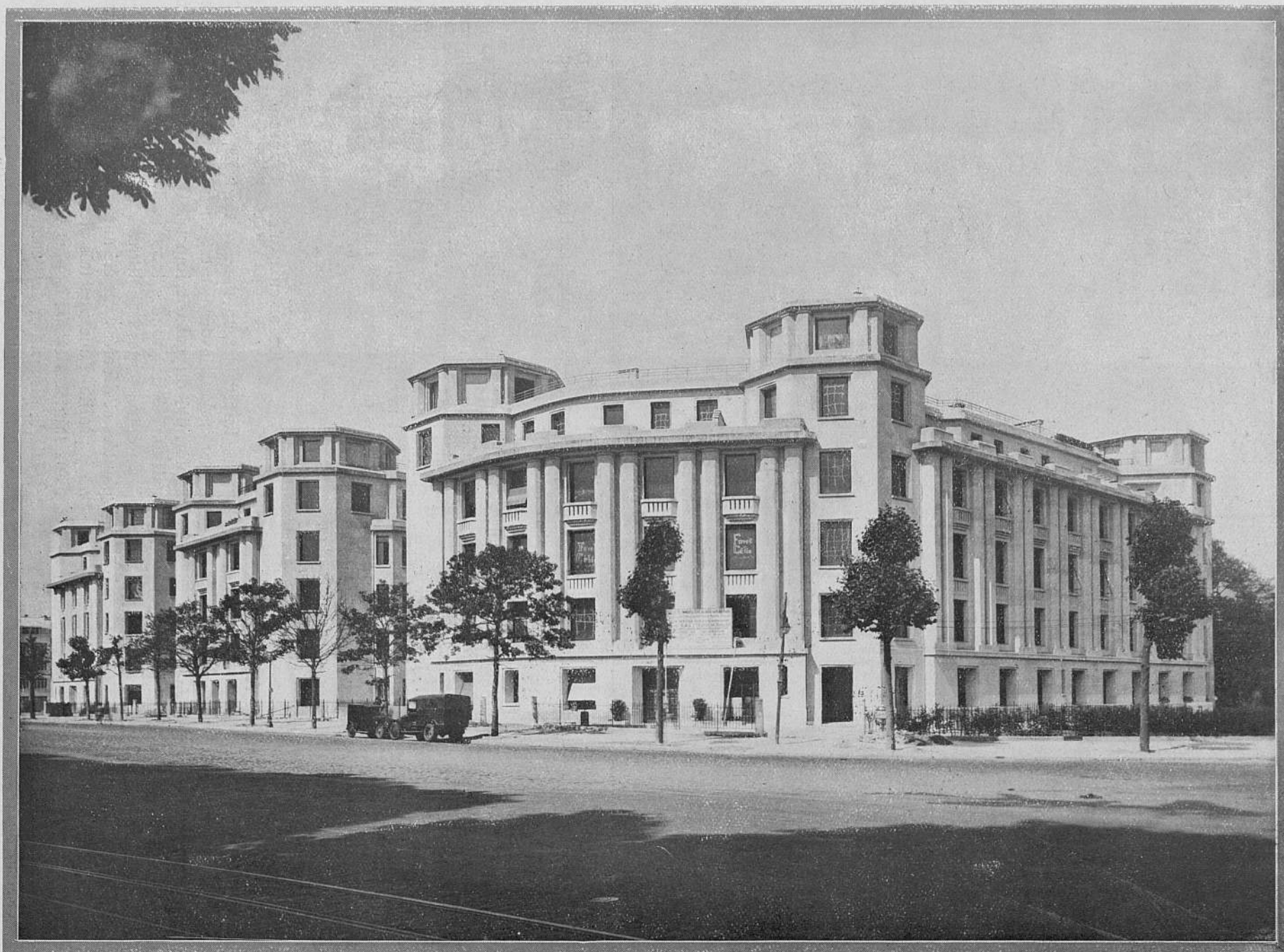
Groupe d'immeubles au Bois de Boulogne : Jean WALTER, Architecte. — Côté place Porte de la Muette (Entrée du Bois).
