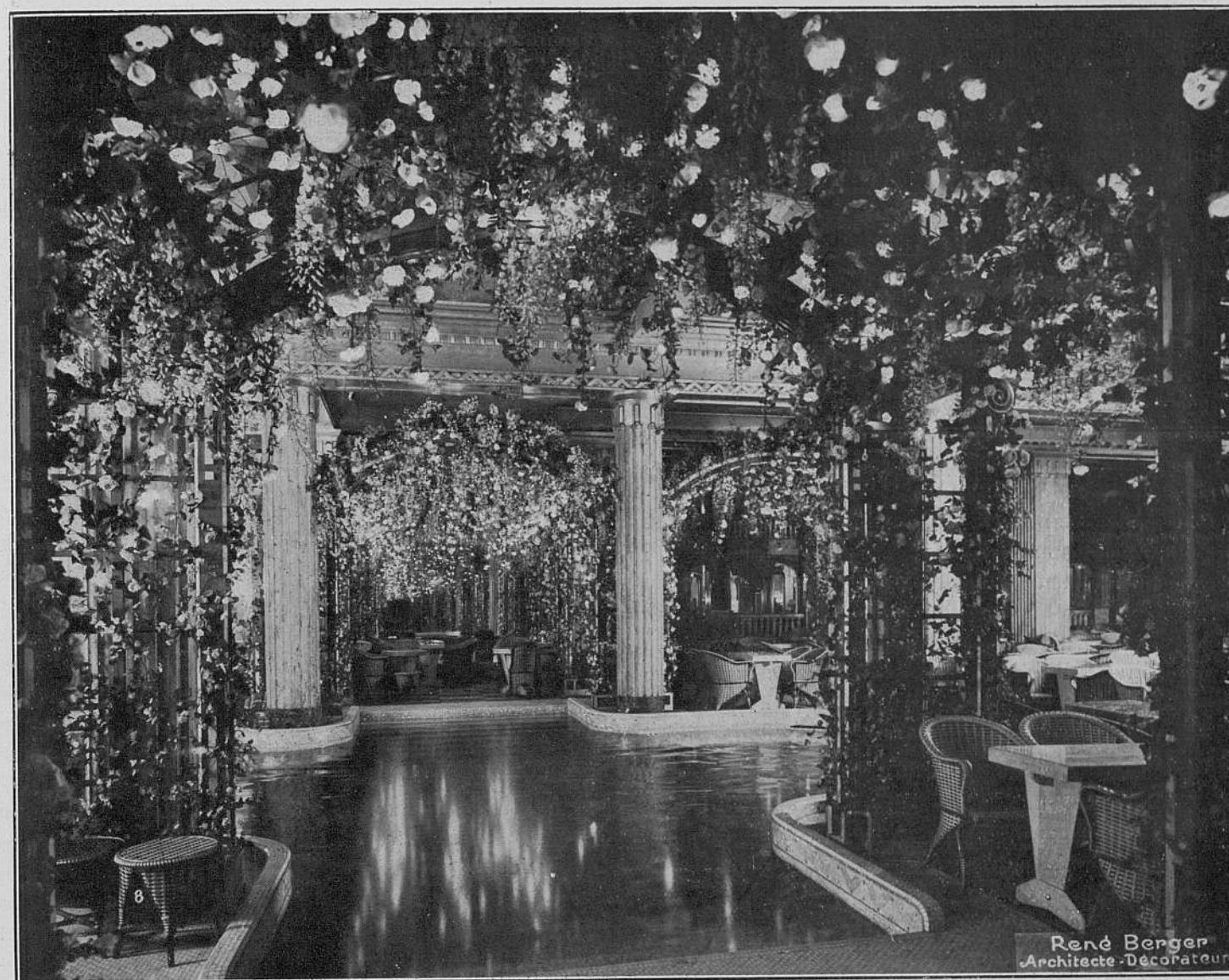
Le Lido. — Piscine et pergolas fleuries : M. René Berger, Architecte.
