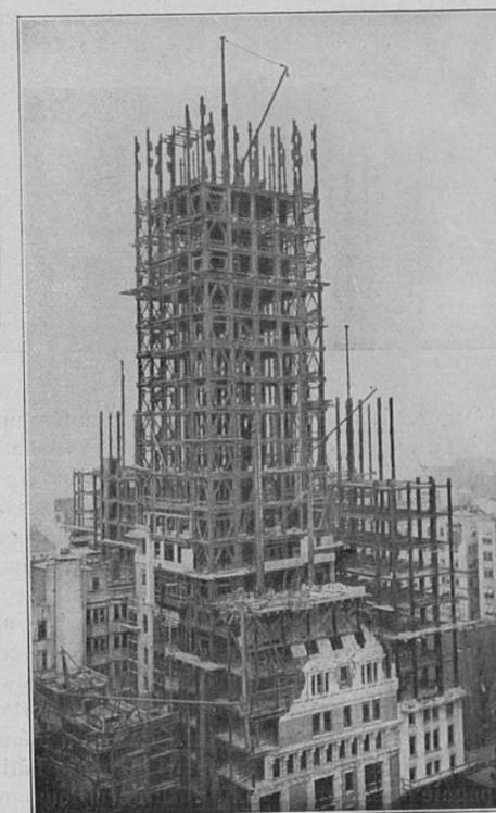
œuvre de la construction ; car ces ouvrages — comme cela s'est passé pour le Singer Building — sont descendus jusqu'à la rencontre de la masse rocheuse, de façon à asseoir tout le poids des armatures métalliques sur le terrain solide. Pour cette opération, on emploie généralement des caissons à air comprimé et les chantiers qu'il faut créer ont une grande importance.
